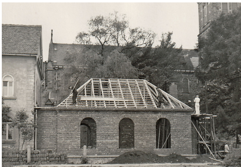
Fota za čas twara - Fotos zur Bauzeit 1954
