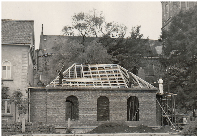
Fota za čas twara - Fotos zur Bauzeit
