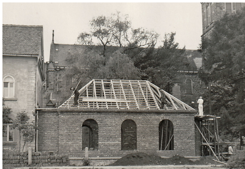
Fota za čas twara - Fotos zur Bauzeit
