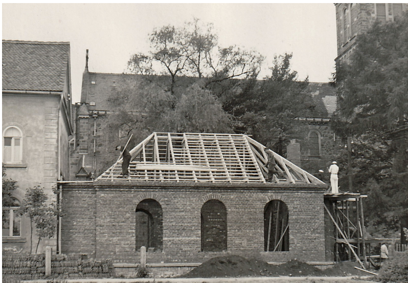
fota za čas twara - Fotos zur Bauzeit
