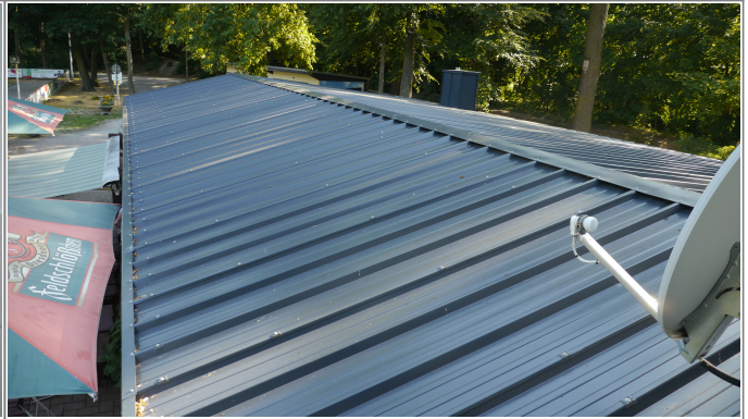
Nowa trzecha z izolaciju za cöplotu Erneueres Dach mit Wärmeisolierung
