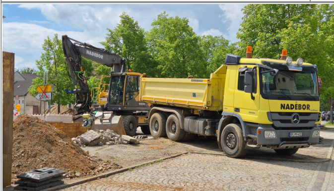
Džěła započinachu so na nawsy - z přizamknjenjom wopłóčkowego kanala (prěni tydžeń)
