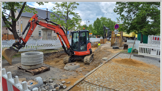
Die Arbeiten begannen auf dem Dorfplatz - mit dem Anschluß an die Abwasserkanalisation (erste Woche)
