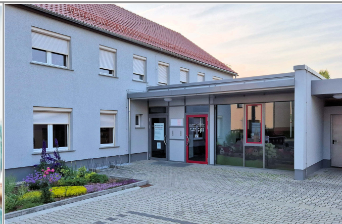
Renovierte Arztpraxis mit neuem Warte- und Thekenbereich
