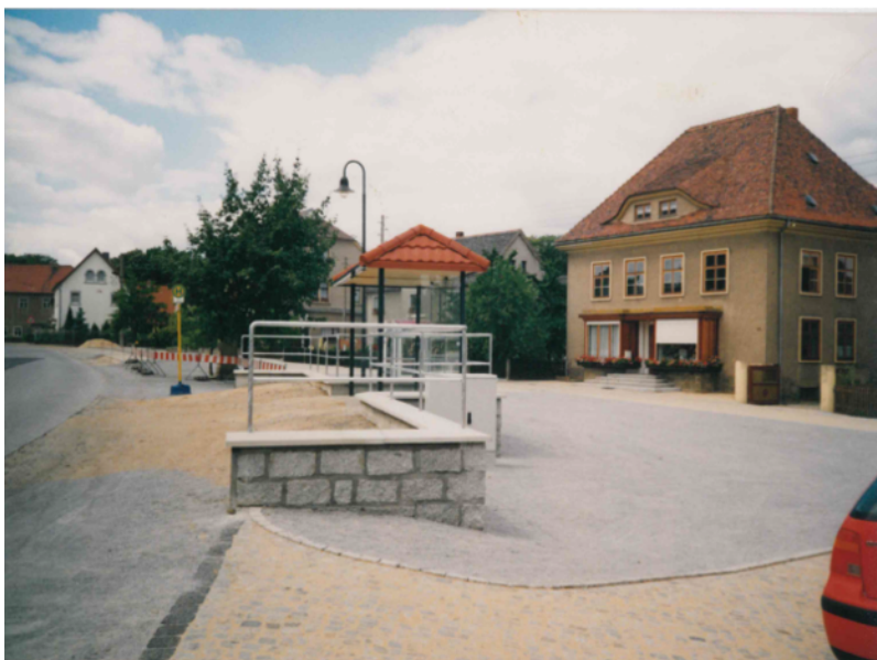
Wobraz z druhej połojcy lěta po zakónčenju 1. fazy porjedźenja - Bild aus der zweiten Jahreshälfte nach Beendigung der 1. Sanierungsphase
